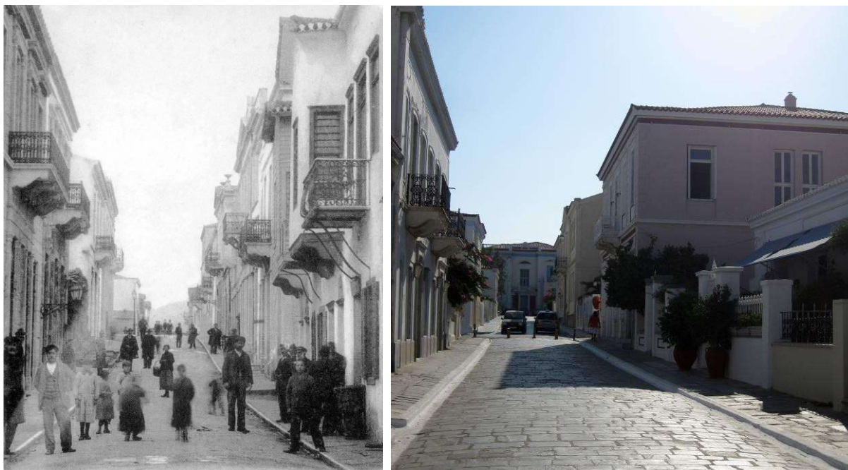
Σχ. 11 και 12. Χώρα Άνδρου. Οδός Γ. Εμπειρικού. Άποψη του δυτικότερου άνω τμήματος. Αριστερά: Carte Postale του 1904 (Σταθάτος 2007). Δεξιά: Αύγουστος 2013. Στο βάθος διακρίνεται η οικία Βογιατζίδη (1917).
