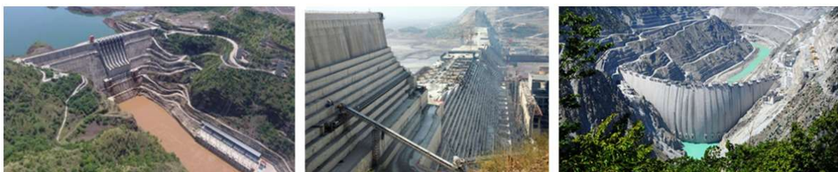
Εικ. 9: Η κατασκευή του φράγματος (πηγή: διαδίκτυο)
